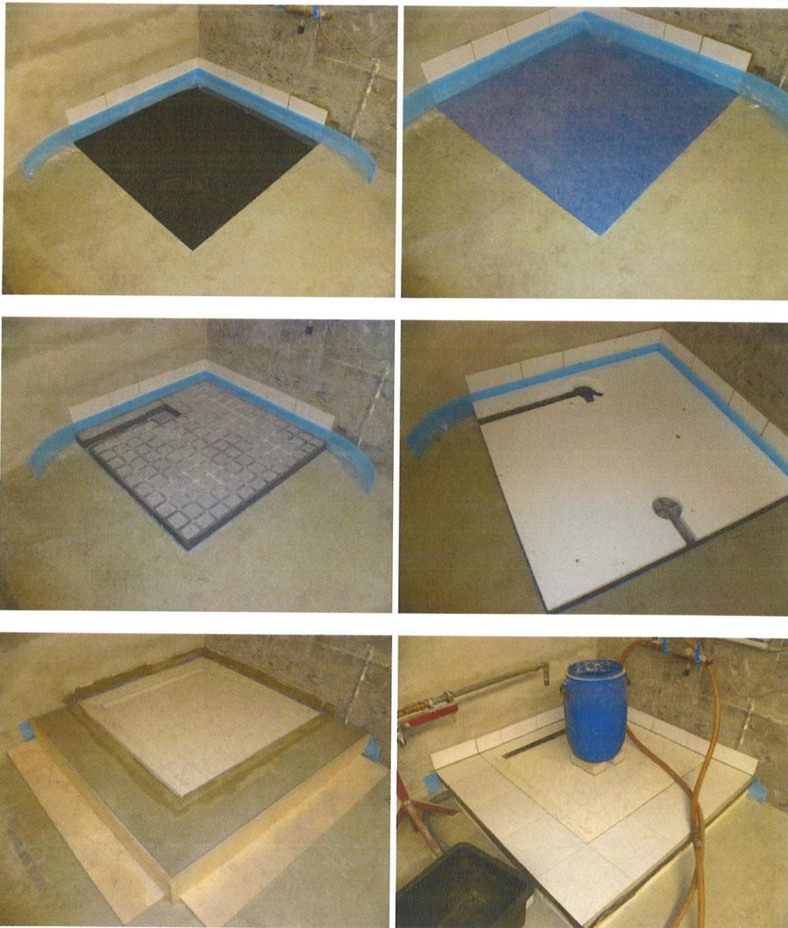
Oben: Gummigranulatmatte aus dem "Schallschutz für Duschelement" lose auf dem Rohboden aufgelegt und mit einer PE-Abdichtungsbahn lose abgedeckt.
