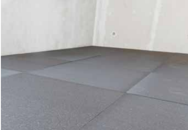
Vollflächige Auslegung der Unterdämmung unter Berücksichtigung der vorhandenen Zuleitungen.
