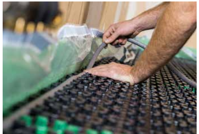
Die Verlegeplatten müssen seitlich zum Randdämmstreifen mittels Rundprofil abgedichtet werden, um ein Eindringen des Estrichs in die Randbereiche zu vermeiden.
