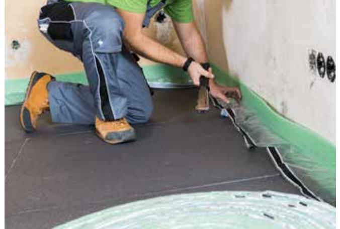
Anbringen des Randdämmstreifens an allen aufsteigenden Bauteilen.
