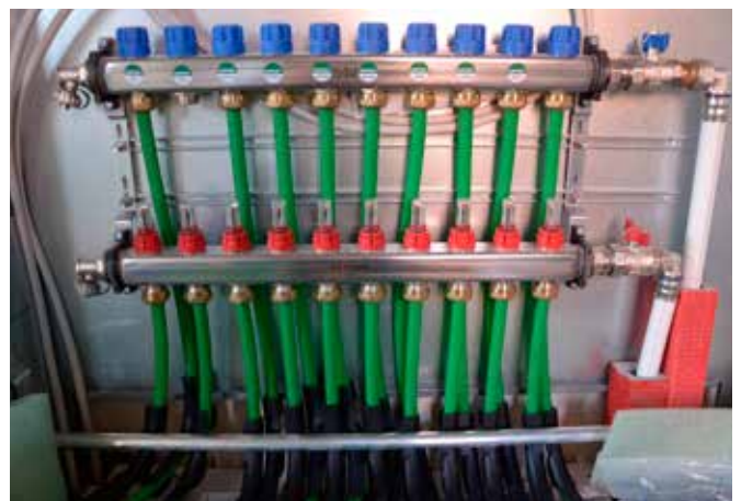
Nach Anschluss der Fußbodenheizungsrohre an den Verteiler erfolgt die Befüllung der Anlage mit Wasser und die Dichtheitsprüfung.
