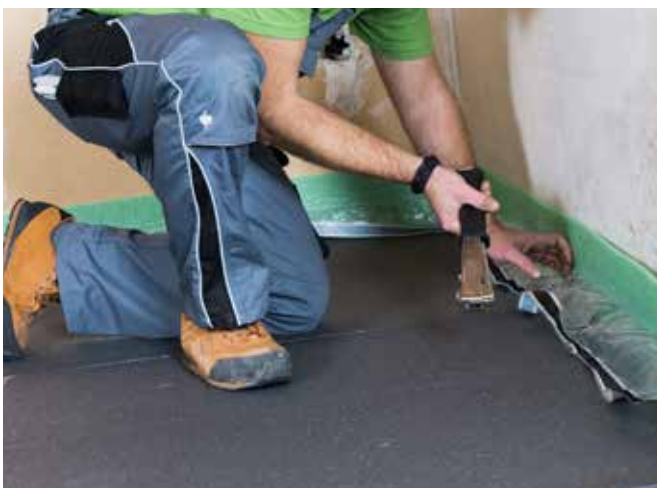
Anbringen des Randdämmstreifens an allen aufsteigenden Bauteilen.
