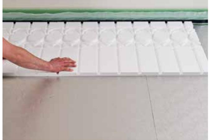
Vollflächige Verlegung der Systemplatten unter Berücksichtigung der Laufrichtung der Nuten.
