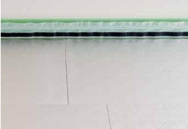
Vollflächige Auslegung der Unterdämmung unter Berücksichtigung der vorhandenen Zuleitungen und Anbringen des Randdämmstreifens.
