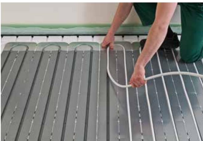
Das Metallverbundrohr ist leicht biegsam und wird mit leichtem Druck in die Bleche eingeklickt.
