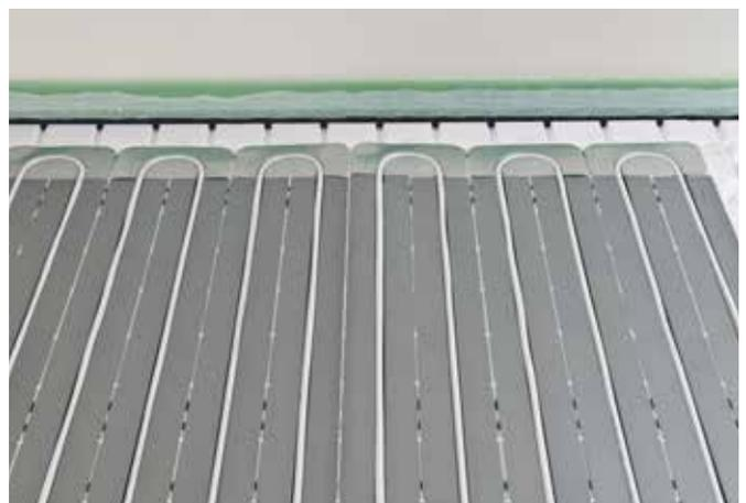
Durch die Klemmwirkung ist das Verbundrohr sicher in der Platte fixiert.
