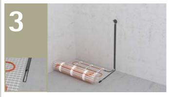
b) Verlegen sie den Kaltleiter (Anschlussleitung Heizmatte) falls erforderlich seitlich der beheizten Fläche bis zur Anschlussdose. Der Kaltleiter darf den Heizleiter nicht kreuzen oder berühren! Halten sie einen Mindestabstand von 2 cm zu den Heizleitern ein.
