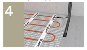
Rollen sie nun die Dünnbettheizmatte etwas ab und entfernen sie dabei die Klebschutzfolie. (Bei größeren Heizmatten ggf. Schrittweise entfernen) Die Verlegung muss mit großer Sorgfalt erfolgen um Beschädigungen zu vermeiden:
