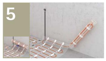
Fixieren Sie die Dünnbettheizmatte gemäß Ihrem Verlegeplan mit der Klebeseite auf dem sauberen Untergrund. Die Heizmatten werden nebeneinander "Bahn für Bahn" verlegt, an der vorgesehenen Wendestelle schneiden Sie das Glasgewebe ein (Achtung: Heizleitung nicht beschädigen!) und verlegen wie in der Abbildung dargestellt. Nachdem die geplante Form der Verlegung erreicht ist, drücken Sie die Dünnbettheizmatte fest auf den Untergrund. Das Trägergewebe muss dabei faltenfrei auf dem Boden liegen.
