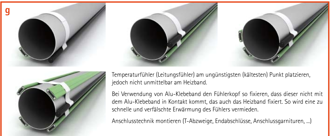
Montage des Zubehörs bei Rohrleitungen des Heizbandes
