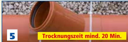
Klebefitting auf Rohrleitung ausrichten, andrücken und mit beiliegenden Kabelbindern fixieren. Überschüssigen Kleber entfernen.
