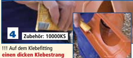
!!! Auf dem Klebefitting einen dicken Klebestrang auftragen ca. 4 mm.
