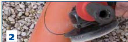
• Schneiden mit Stichsäge oder Winkelschleifer.
