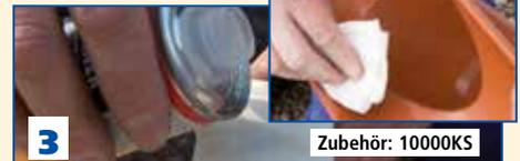
• Rohr und Fitting mit PVC-U-Reiniger reinigen.
